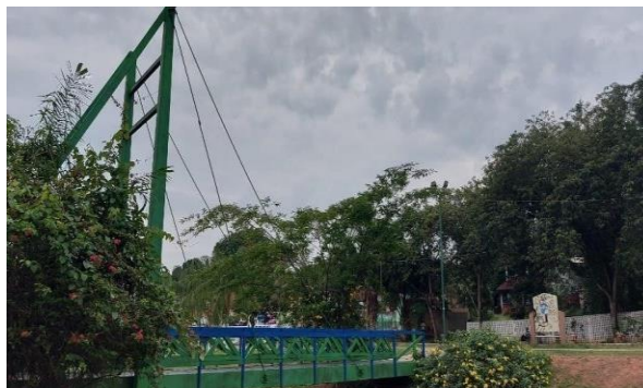
Imagem 06: Ponte Canal da Maternidade
